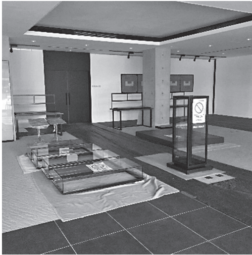
工事中の常設展示室兼ラウンジ
