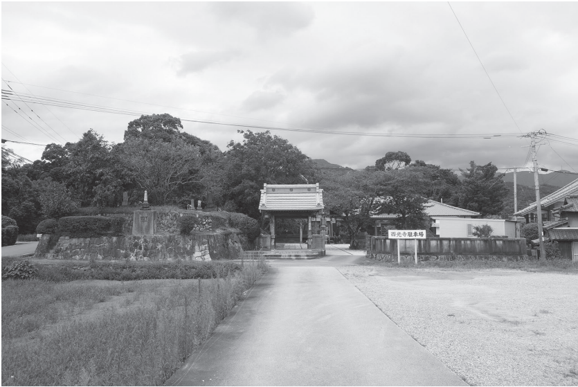
図1 西光寺正面全景（左側石垣上に納骨塔） ※筆者撮影
