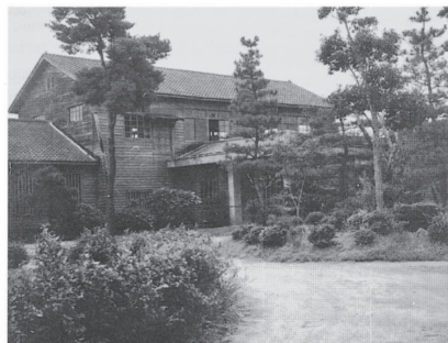
正面玄関と事務本館
