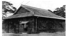
1918年大名町の旧神学校から西 新校地に移築された雨天体操場 （ドージャー 2016 p. 45）
