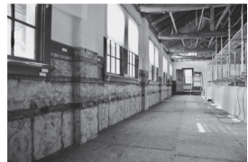
2004年11月改修工事中の 講堂3階(筆者撮影)
