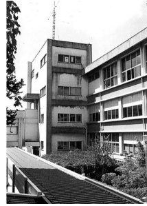
1971年竣工高等学校文化館は南側を渡り廊下で西校舎と接続 (40 p.38)
