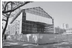
2004年11月改修工事中の旧本館・講堂 右後方には法科大学院棟と工事中の大学院、左後方にはクロスプラザが見える(筆者撮影)
