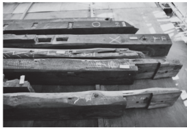
2004年12月改修工事中の 解体当初材(筆者撮影)
