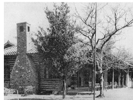
1952年竣工の修養会館（干隈校地）は解体された高等学校木造西校舎の当初材を再利用 (70下 p. 46)
