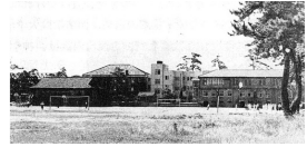
1950年代 右から高等学校物象館、西校舎、講堂、第2体育館(旧雨天体操場)、後方は解体中の木造東校舎か(100通 p.155)
