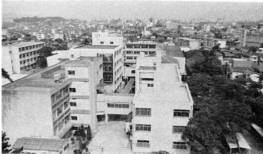
1980年代 中央キャンパス本部・本館から眺めた高等学校校舎 左手前から奥に文化館、本館、体育館（一部） 右手前から西校舎、講堂、東校舎、正面奥に北校舎、 中央2ヶ所に渡り廊下が見える (70下 p.290)
