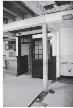
2004年11月改修工事中の 旧本館1階(筆者撮影)
