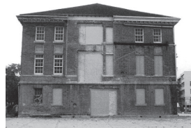
2003年改修前の旧本館・講堂 東壁開口部をセメントで封印 (改修報告書 2006 写真 p. 3)
