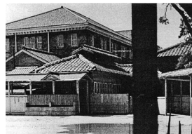
1956年頃スレート葺から瓦葺になった講堂屋根 (ヴォーリス 2003 p. 2-1-5-9)
