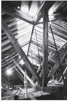
2004年11月改修工事中の 屋根裏小屋組(筆者撮影)
