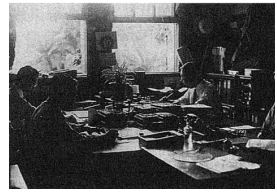
1939年本館玄関東側事務室 (100通 p. 665)
