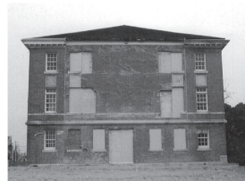
2003年改修前の旧本館・講堂 西壁開口部をセメントで封印 (改修報告書 2006 写真 p. 4)
