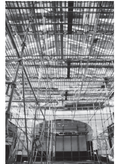
2004年12月改修工事中の 講堂2階(筆者撮影)
