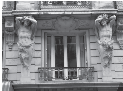
パリ5区ダンテ通りの建物外壁
