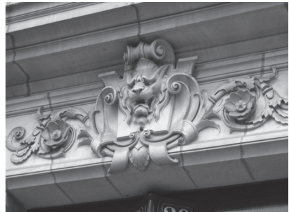
パリ5区サン・ジェルマン通りの建物外壁
