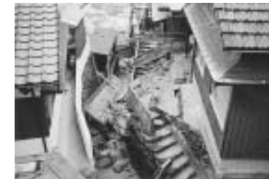
図9 擁壁崩壊に伴うブロック塀の倒壊（2005年4月2日撮影）
