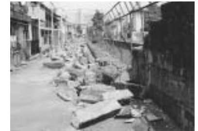
(b) 倒壊した石塀
