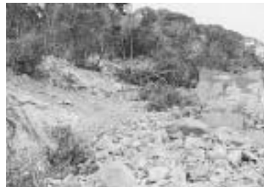
(b) 斜面崩壊の源頭部 (2005 年 4 月 23 日撮影)
