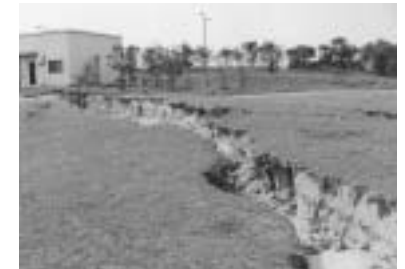
(b) 「光と風の広場」カモ池北崖 付近の地すべり性亀裂 (2005年4月23日撮影)
