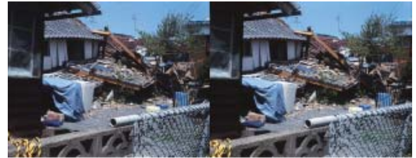
(d) 倒壊した家屋 (玄界島)
