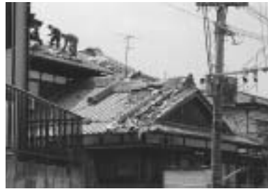
(b) 落下した屋根瓦 (南区南大橋) (2005年4月21日撮影)
