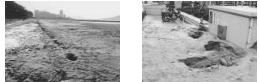
(a) 人工砂浜の噴砂跡 (b) 福岡タワー下の大量の噴砂跡
