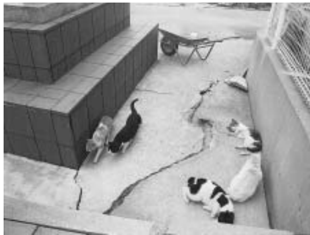
図12 玄界島公民館前の石碑基礎部分に生じた亀裂(2005年4月2日撮影)
