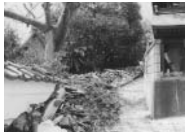
(b) 倒壊した土塀 (2005年4月1日撮影)
