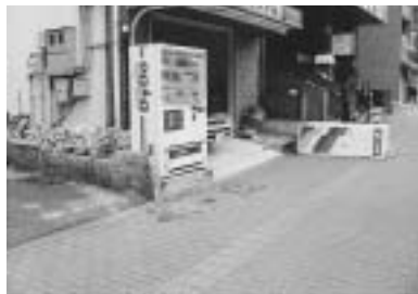
(a) 倒壊したブロック塀と自動販売機
