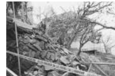
図10 玄界島小学校南端の石垣崩壊（2005年4月2日撮影）
