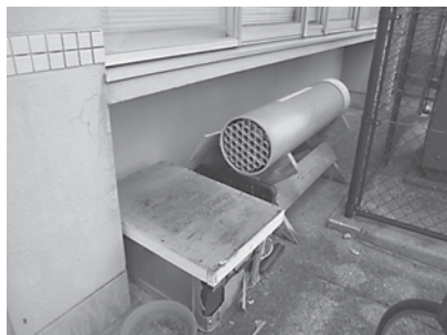
写真53 室内にスペースがない場所
